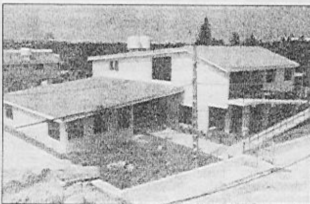
Das von Brigaden der DKP und kubanischen Bauarbeitern errichtete Gesundheitszentrum in Matanzas. Im Hintergrund links die Familienarztpraxis „Tamara Bunke“, im Vordergrund das Reha-Zentrum „Comandante Ernesto Buschmann“
