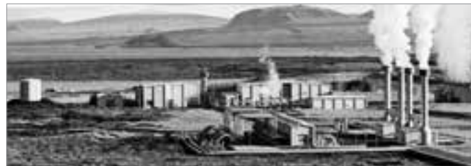
Das staatseigene Geothermische Kraftwerk in Nesjavellir versorgt Islands Hauptstadt Reykjavik mit Elektroenergie und heißem Wasser.
