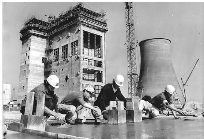
14. Oktober 1971, Baustelle des Kraftwerks „Völkerfreundschaft“ Hagenwerder im Kreis Görlitz, das in RGW-Kooperation mit der VR Polen entstand. 2015 wurden die letzten Anlagen gesprengt
