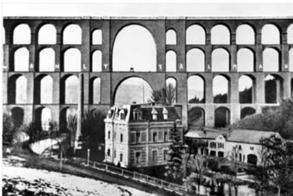
Acht Mylauer Kommunisten brachten unmittelbar vor den Reichspräsidentenwahlen in der Nacht vom 12. zum 13. März 1932 diese Losung in 48 m Höhe an den Pfeilern der Göltzschtalbrücke an. Eingessandt von Paul Fiedler, Berlin
