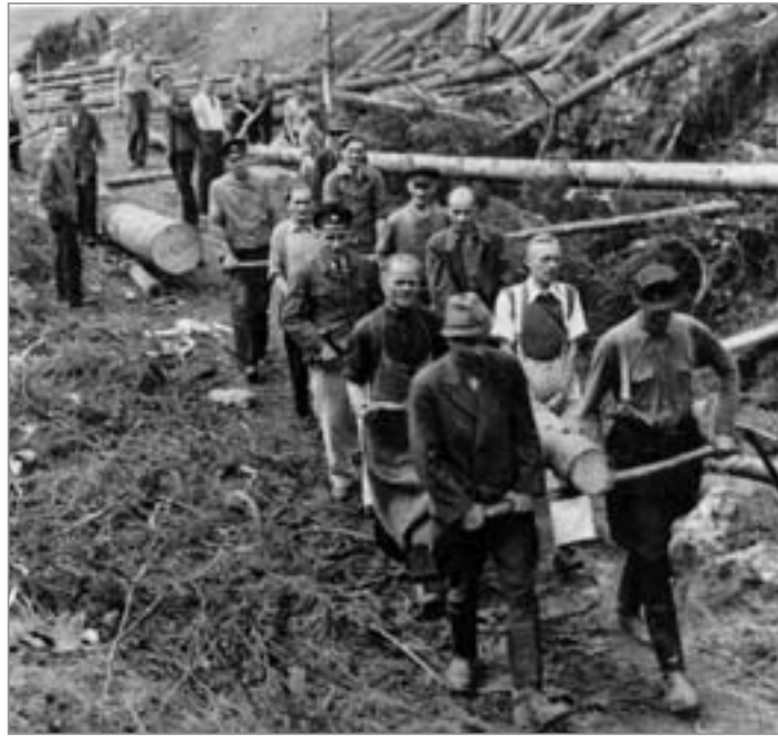
Volkspolizisten helfen beim Bau der Talsperre Sosa Foto: Rudi Brocke
