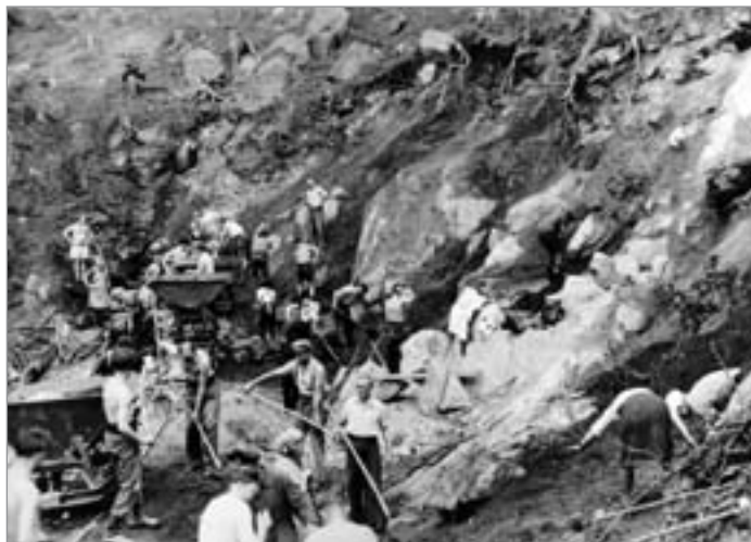
Sie legten durch ihre freiwillige Arbeit einen Grundstein für die DDR: Volkspolizisten beim Bau der Talsperre Sosa
