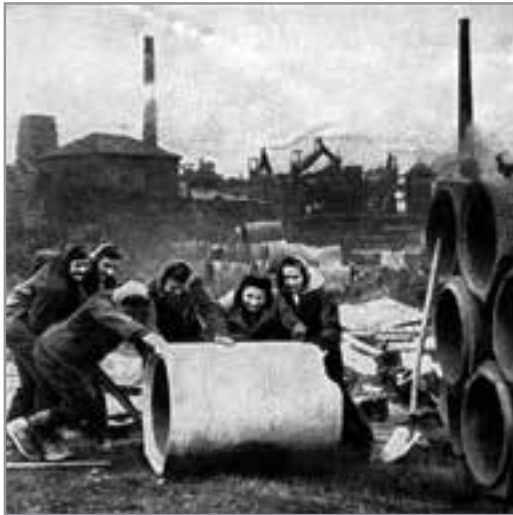
Arbeiten am Bau der Wasserleitung
