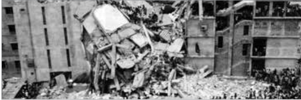
Der achtstöckige „Neubau“ in Savar nach der Katastrophe
