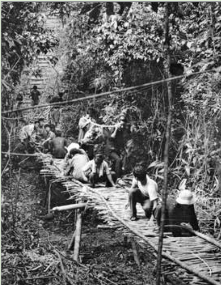
Arbeiter reparieren einen auf Pfählen beruhenden Abschnitt des Hô-Chi-Minh-Pfades durch den vietnamesischen Dschungel.
