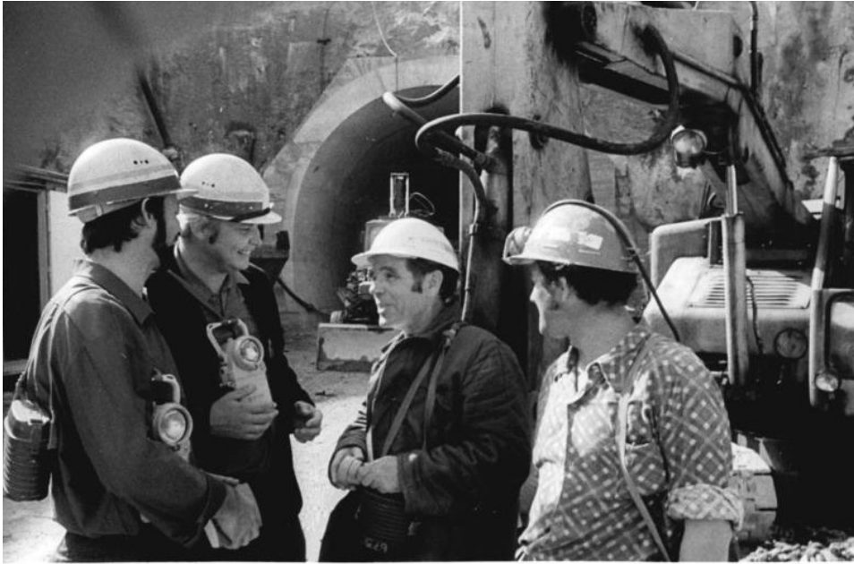
Deutsche und polnische Arbeiter beim Bau des Pumpspeicherwerkes Markersbach in der DDR 1975
